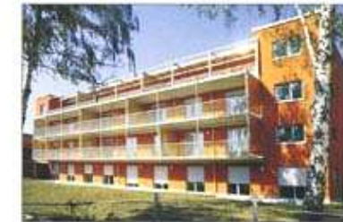
NettWork - barrierefreies MFH mit Aufzug
