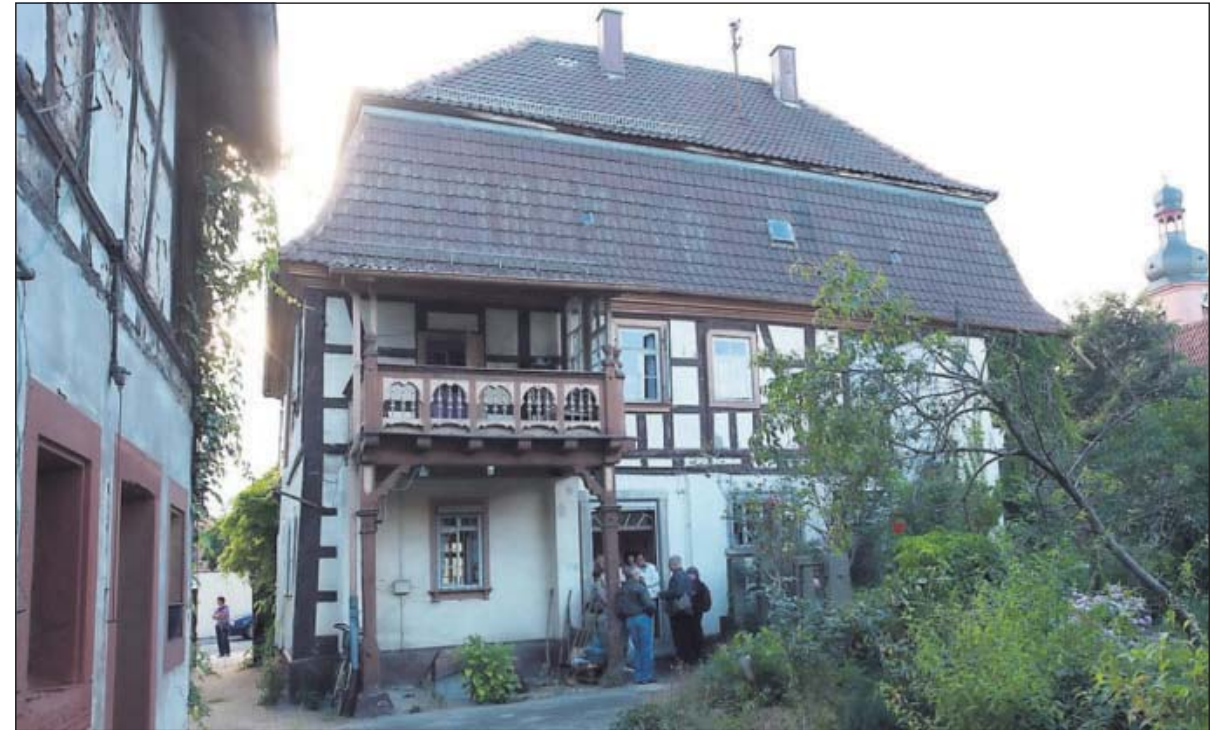
Die derzeitige Hausansicht vom Hof aus: Das denkmalgeschützte Gebäude am Erlenbach wird saniert und bietet mit dem Neubau zusammen Platz für etwa zwölf Wohnungen.
