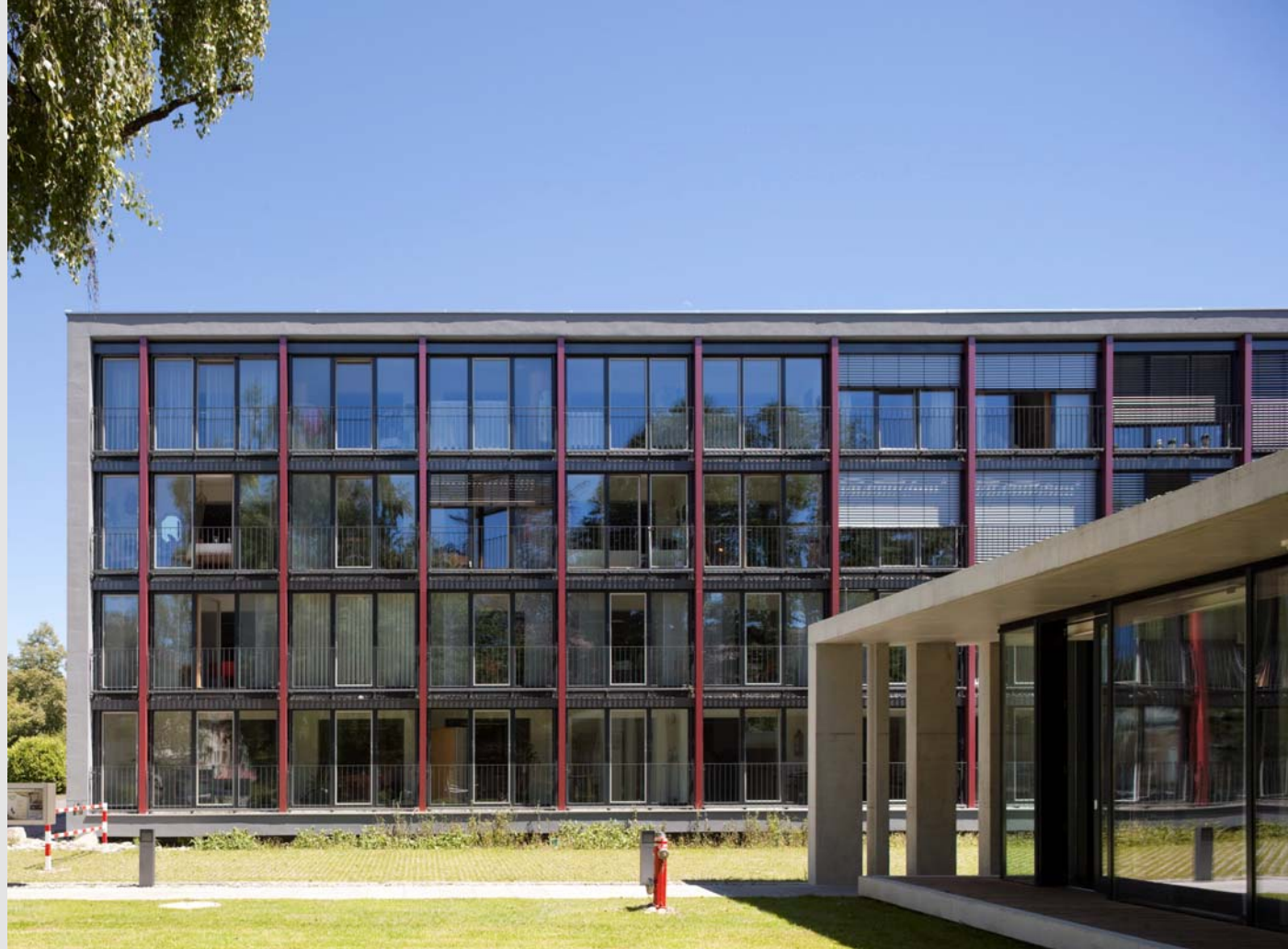
Feierabendheim Konstanz nach der Sanierung
