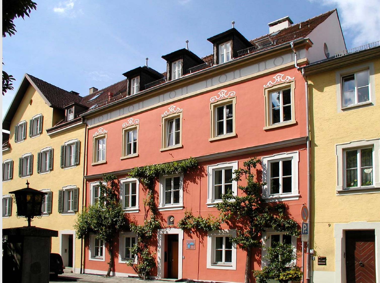
Wohn- und Bürohaus, Ellwangen; Architekt: Wolfgang Helmle
